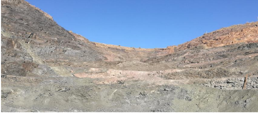
图 2-7 北采场北端靠近滦河边帮无跌水、渗水现象
