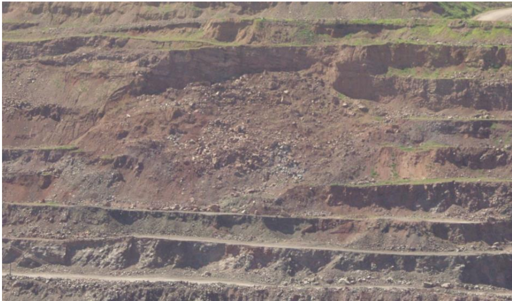
照片 3-4 下盘破碎站下方滑坡体治理后（历史影像，镜向东）
