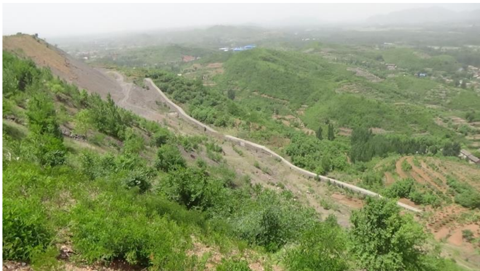
照片 2-25 高台子村南挡土墙
