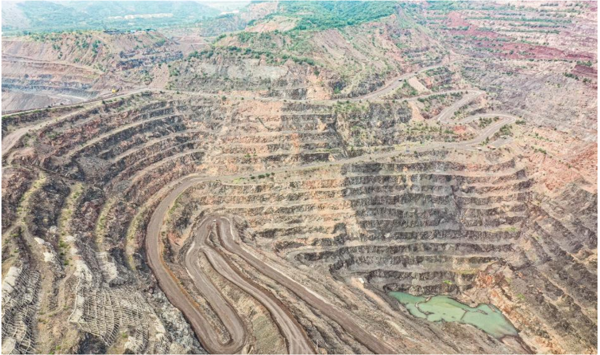
照片 3-12 北露天采场南部边坡现状（镜向西南）
