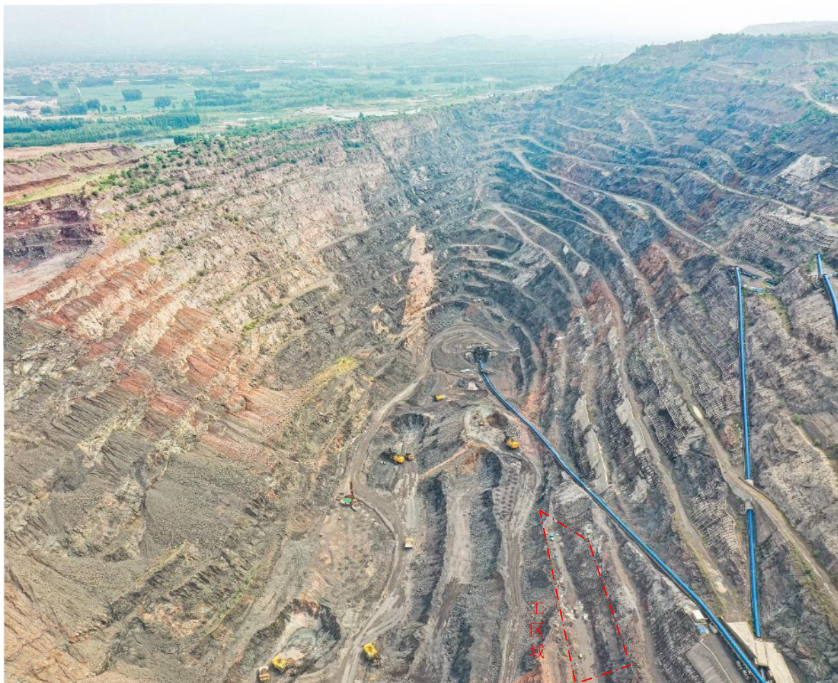
照片 3-11 北露天采场北部边坡现状（镜向东北）
