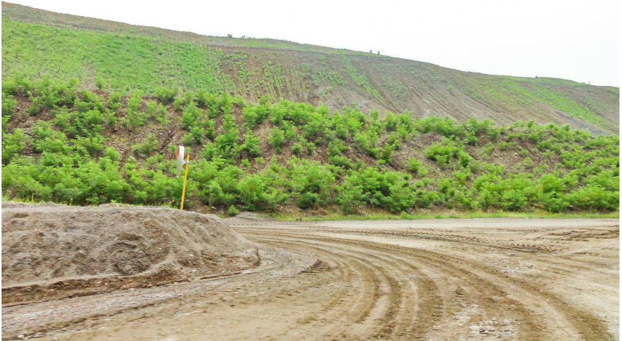
照片 3-47 河西排土场北部边坡绿化治理 镜向南
