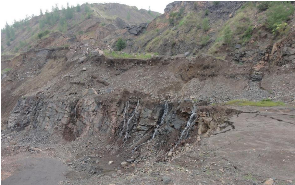
照片 2-9 北采场南端地方蓄水采坑向水厂南采场渗水
