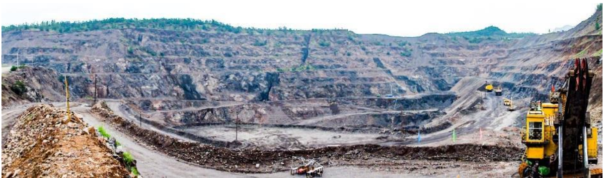
照片 3-13 南露天采场边坡现状（镜向东南）
