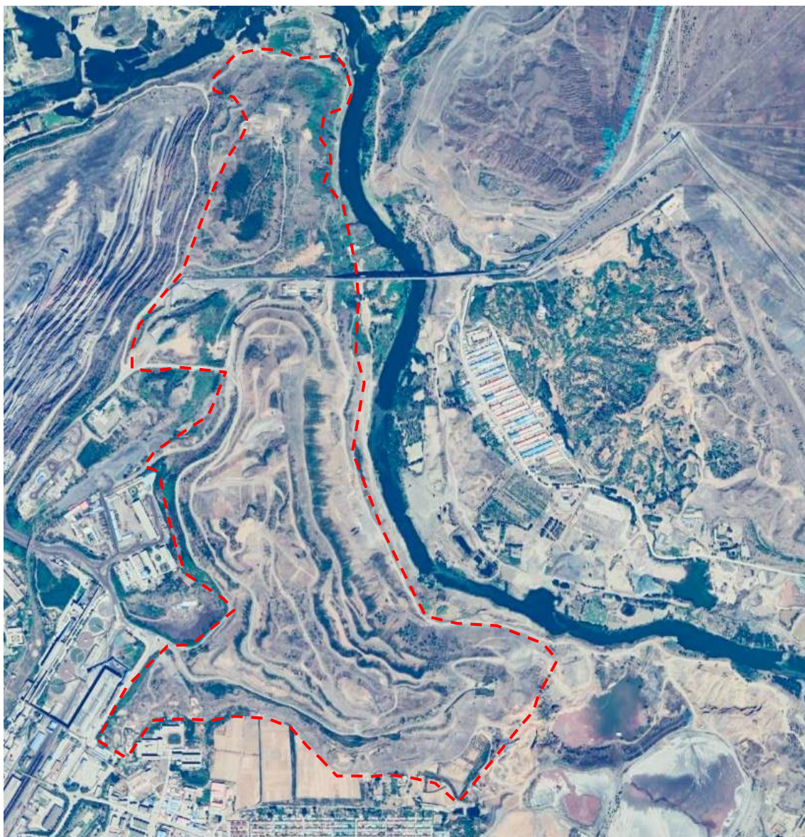
照片 3-28 印子峪排土场卫星影像图
