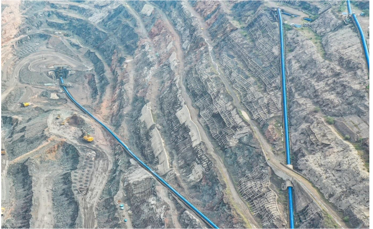
照片 2-12 北采场东边坡中部护坡治理
