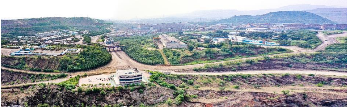
照片 3-14 工业场地现状（镜向东南）
