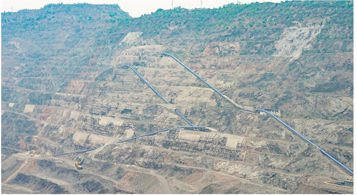
照片 2-10 北采场东边坡中北部护坡治理
