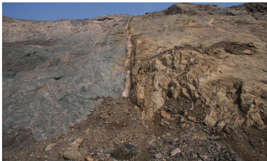
照片 3-1 北采场东坡崩塌治理前（历史影像）
