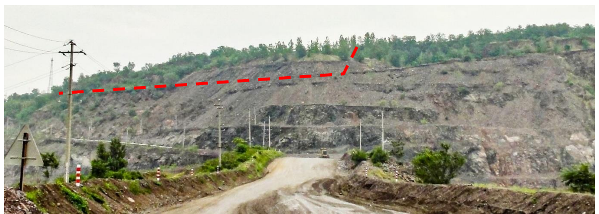
照片 3-23 副井工业场地西侧边坡
