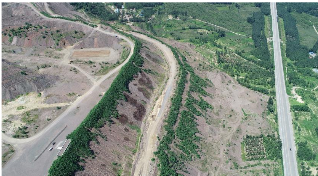
照片 2-35 河东排土场边坡绿化效果
