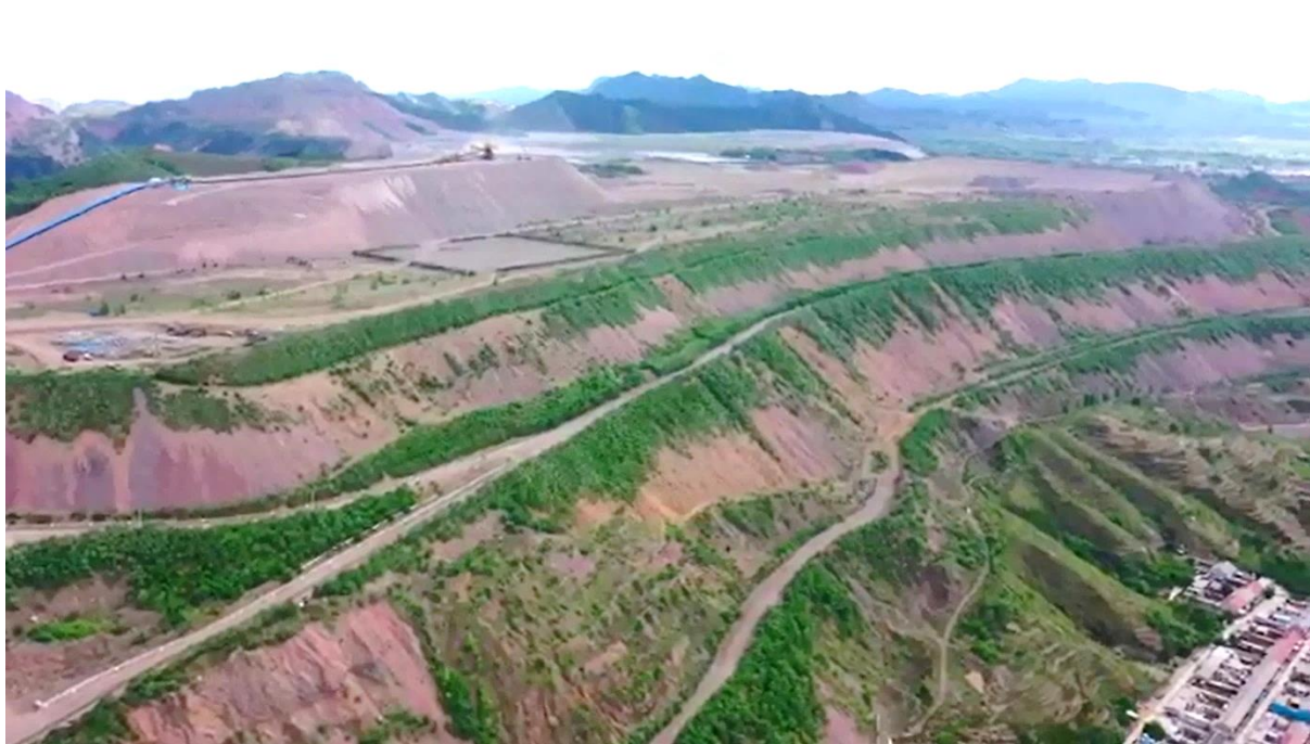
照片 1-4 河西排土场航拍照片
