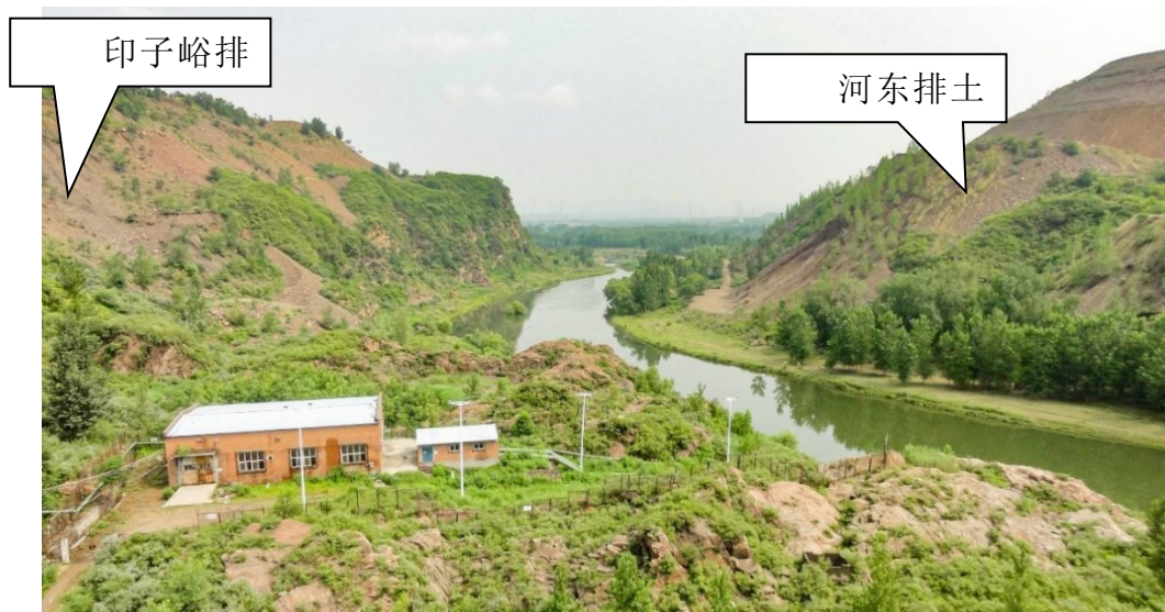
照片 3-21 河东排土场和印子峪排土场滦河过水断面（镜向北）
