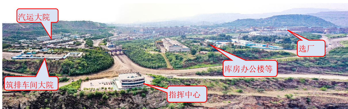
照片 1-6 工业场地航拍照片
