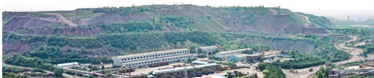
照片 2-31 印子峪排土场西、南部绿化效果（远景）
