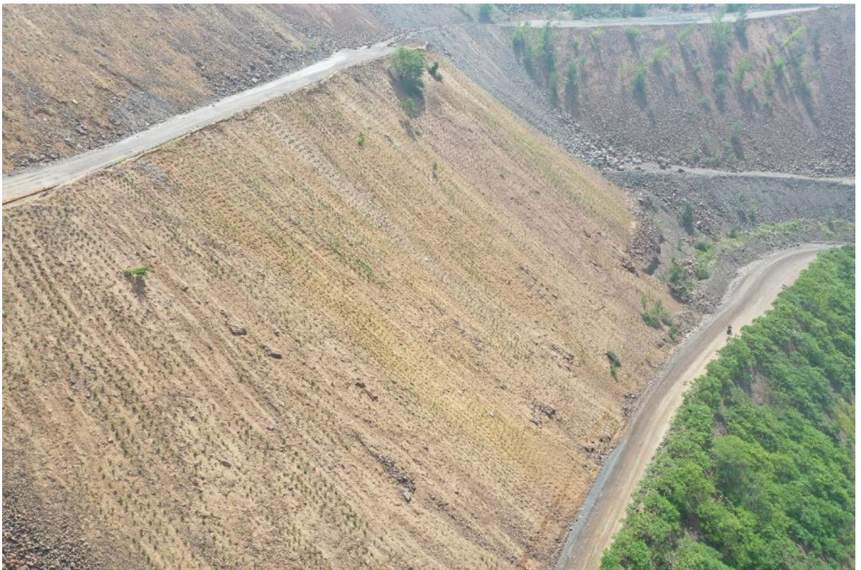
照片 3-50 西南边坡绿化 镜向东南
