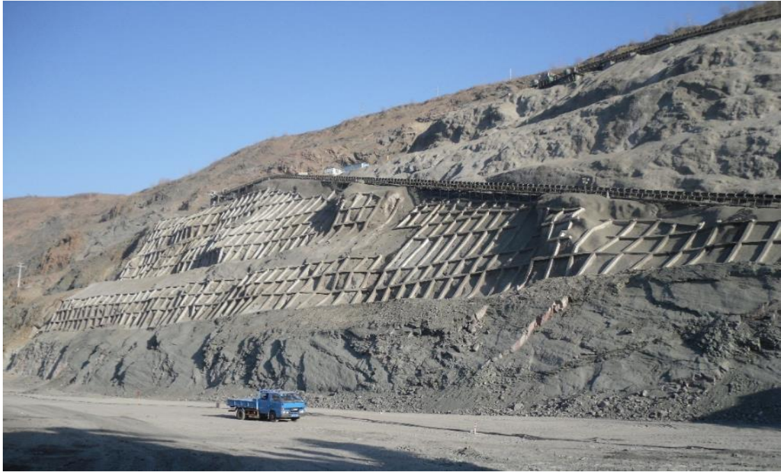
照片 3-6 K2 路基下方+10m~-35m 水平边坡滑坡体治理后（历史影像）
