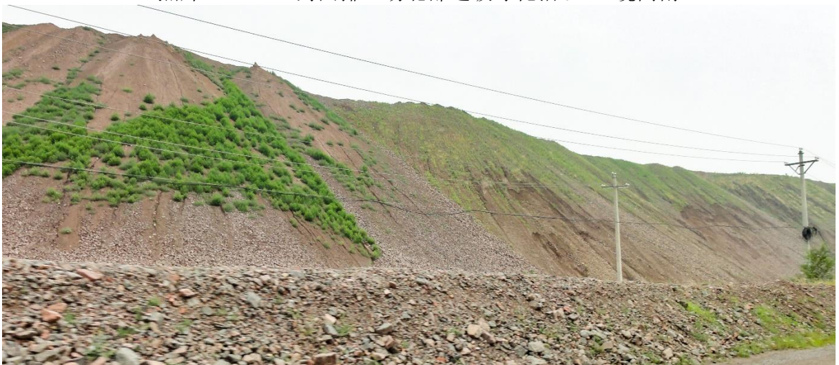
照片 3-48 河西排土场南部边坡绿化治理 镜向北
