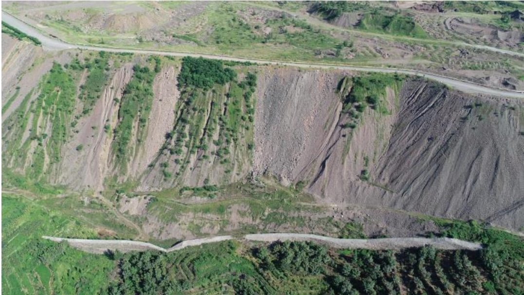
照片 3-16 河西排土场高台子村南重力挡墙
