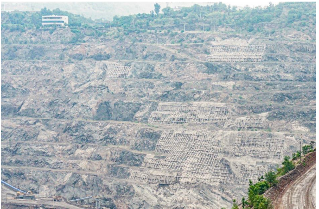
照片 2-11 北采场东边坡南部护坡治理
