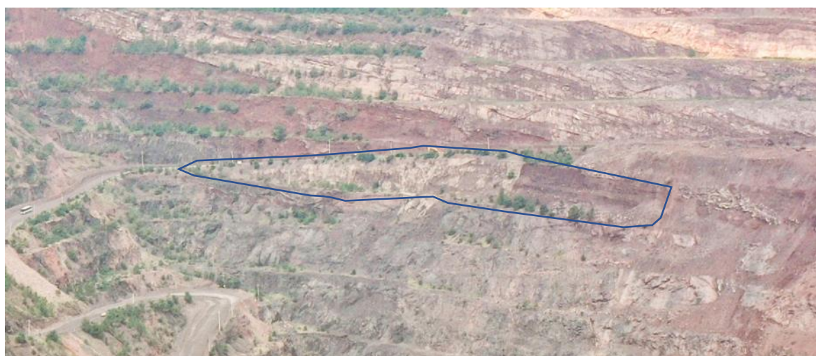
照片 2-13 北采场西边坡南部护坡治理
