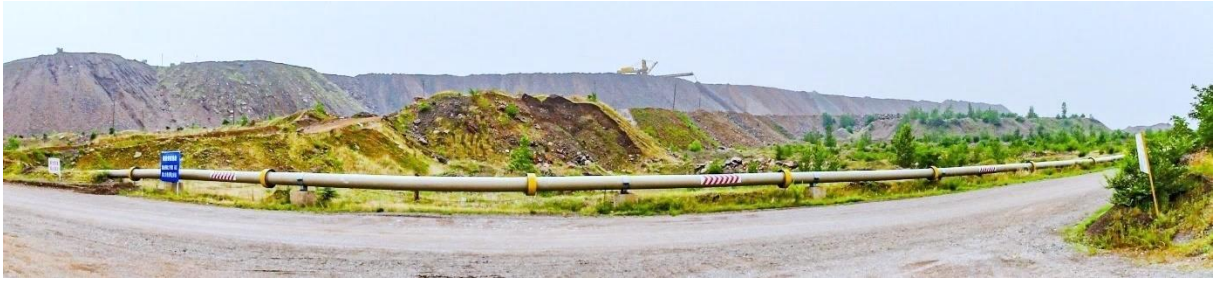
照片 3-34 河西排土场西北部 220m 台阶 镜向南
