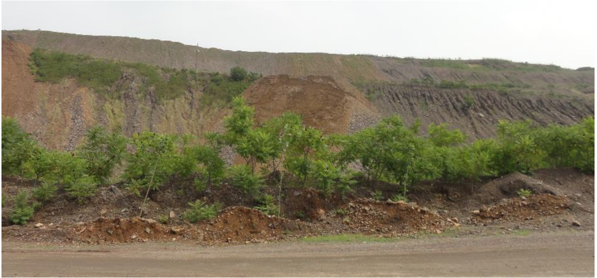
照片 3-43 河东排土场西南边坡 镜向北
