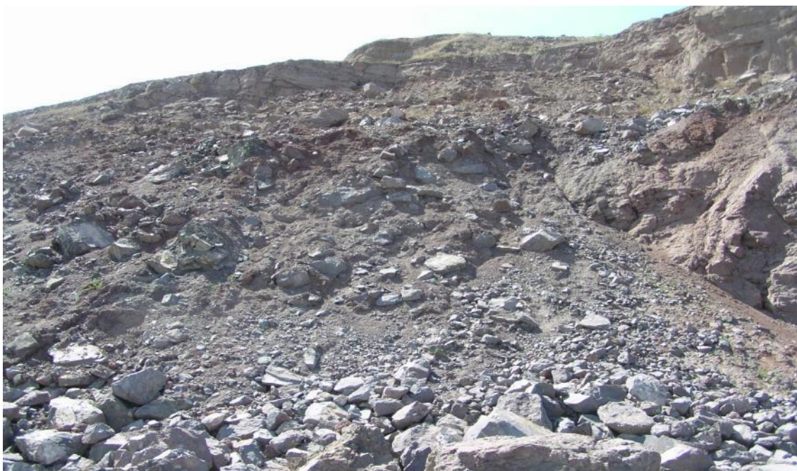
照片 2-23 北采场上盘 D5 机道滑坡体治理施工现场
