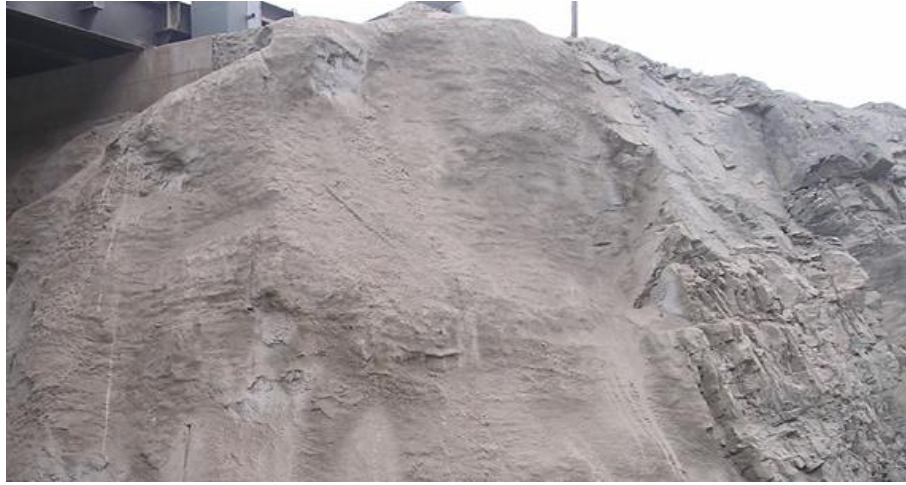
照片 3-2 北采场东边坡崩塌治理后
