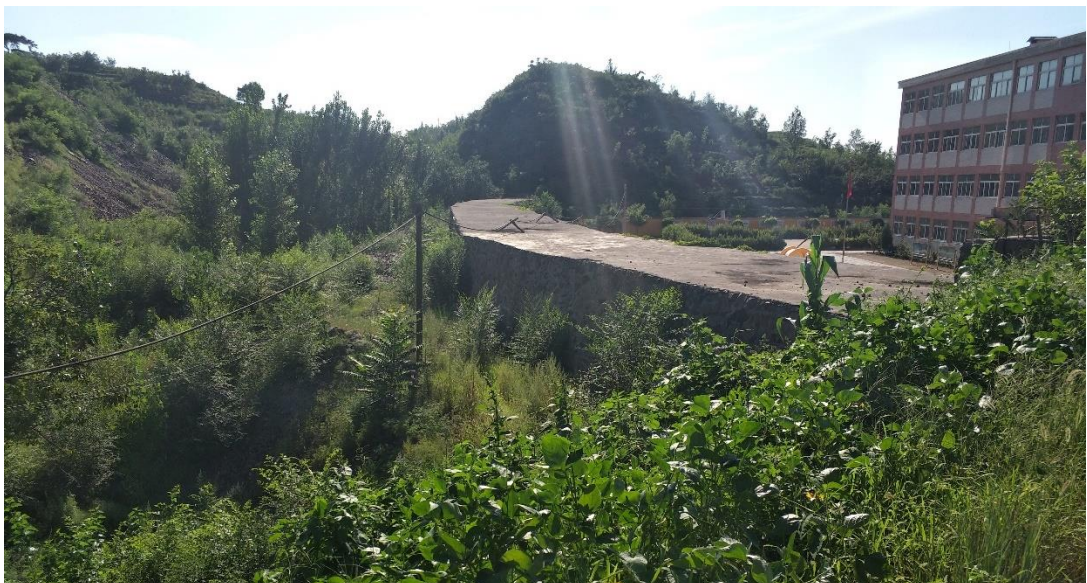
照片 3-15 河西排土场高峪小学南侧重力挡墙
