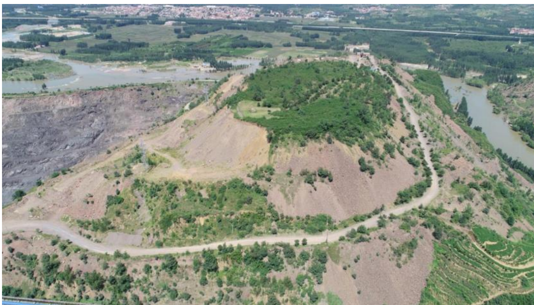
照片 2-30 印子峪排土场北部绿化效果（远景）
