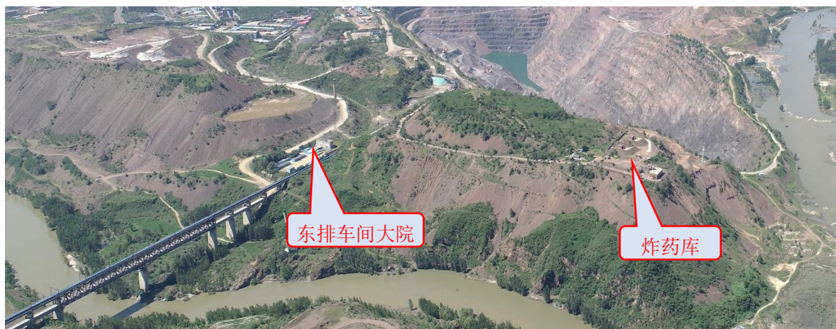
照片 1-5 印子峪排土场航拍照片
