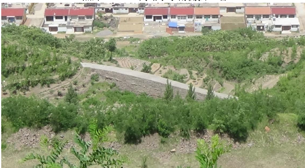
照片 2-27 高峪村南挡土墙
