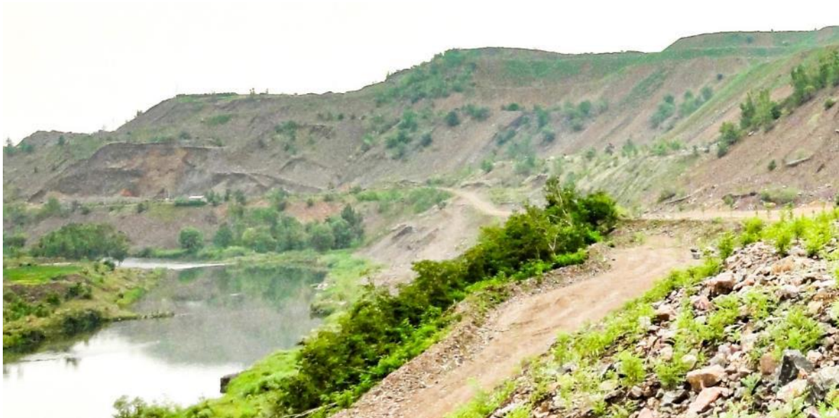
照片 3-20 印子峪排土场滦河沿岸现状
