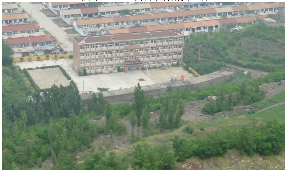
照片 2-26 高峪小学南侧挡土墙
